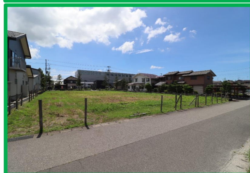
(北側から) 現地
